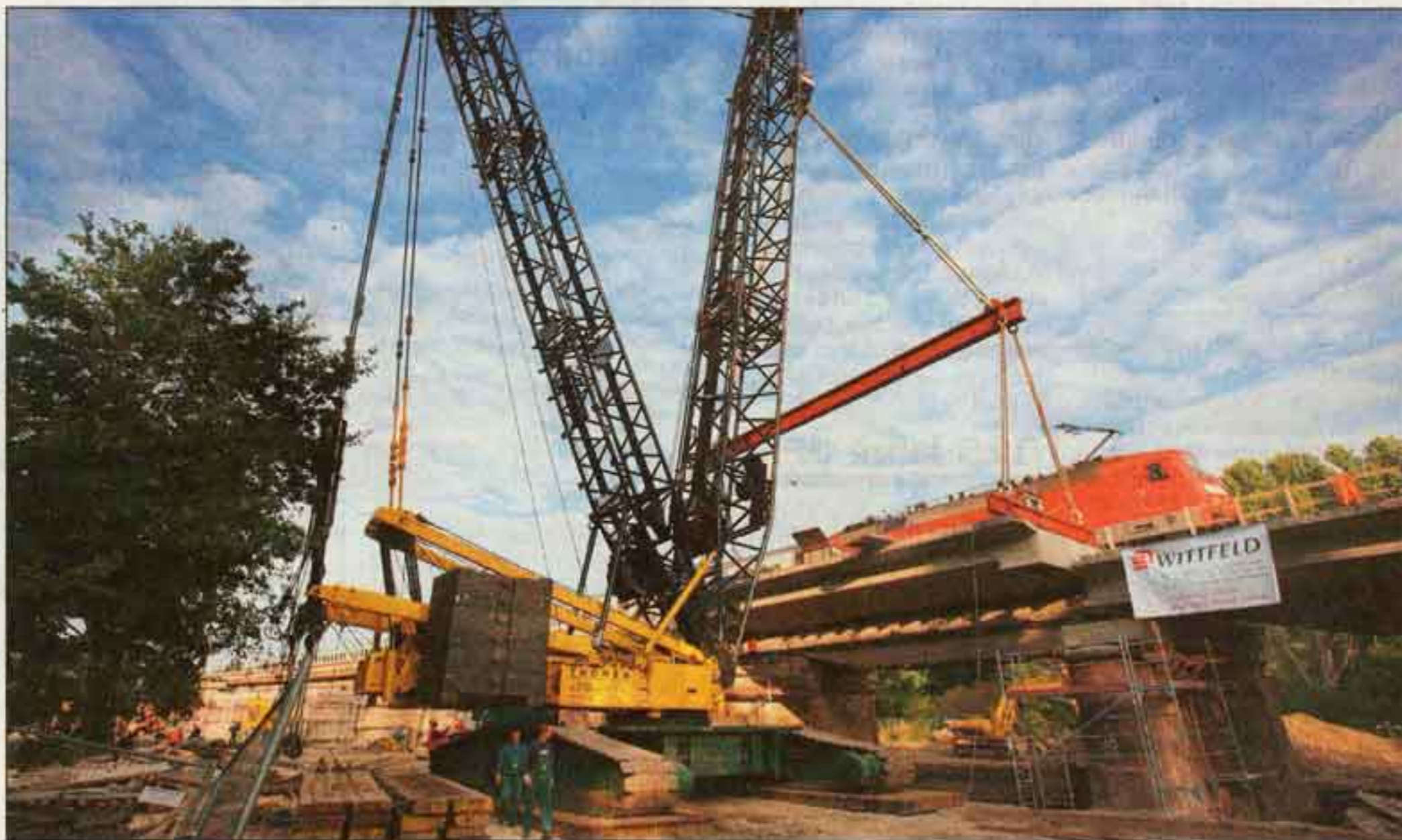
Die neuen Brückenelemente werden von einem Kran bei laufendem Zugverkehr eingehoben.
