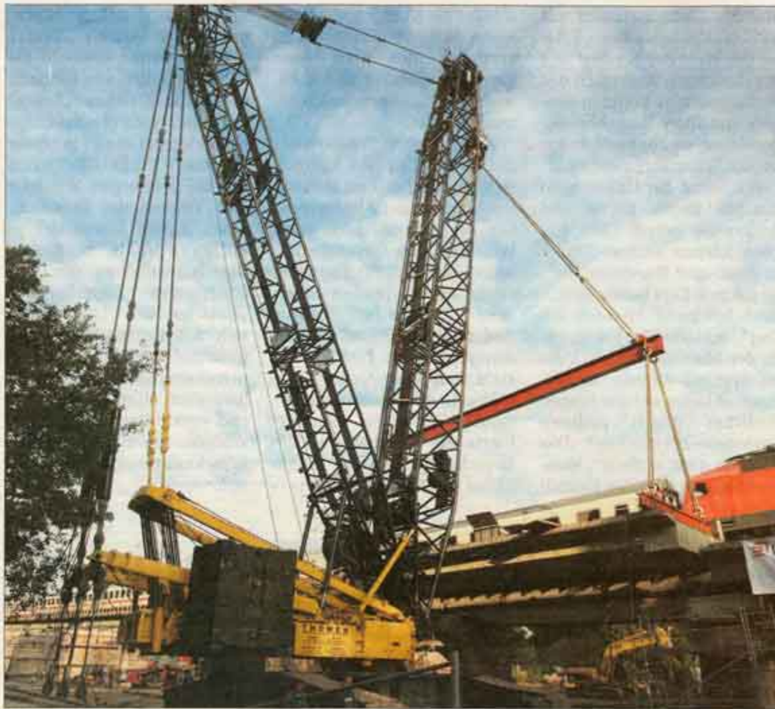
Der 34 Meter hohe Kran kann Lasten von bis zu 850 Tonnen bewältigen. ■ Foto: Harry Braun
